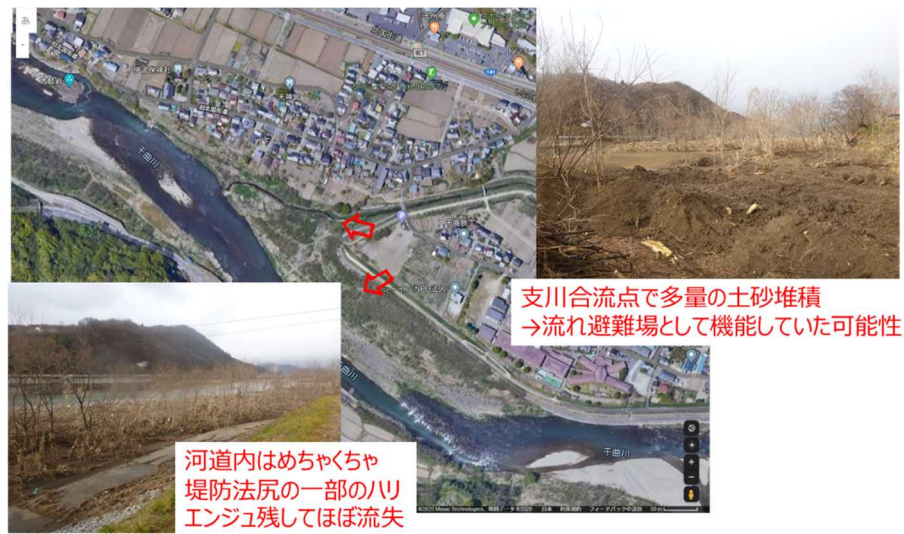
図 2-3-10 支川合流部の状況（生田観測所対岸）
