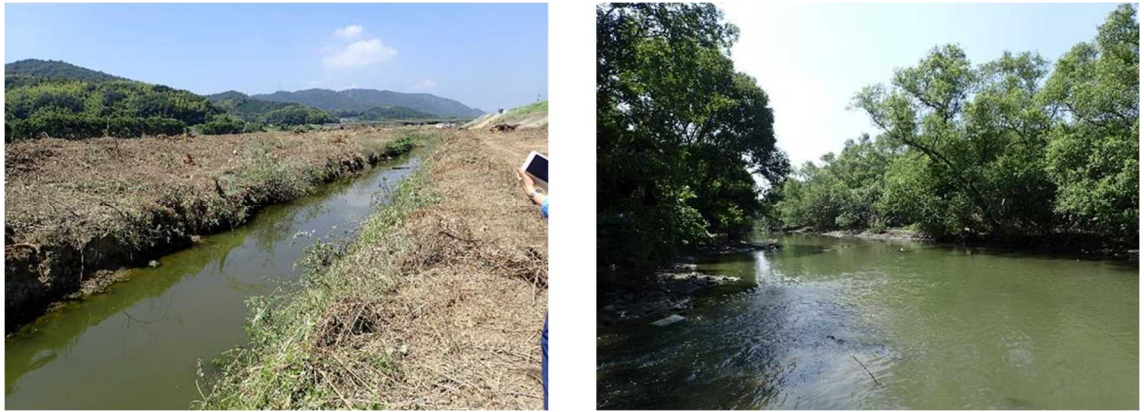
図 2-2-17 大規模な樹木伐開による河川内小水域への影響 (左：伐採箇所、右：未伐採箇所)
