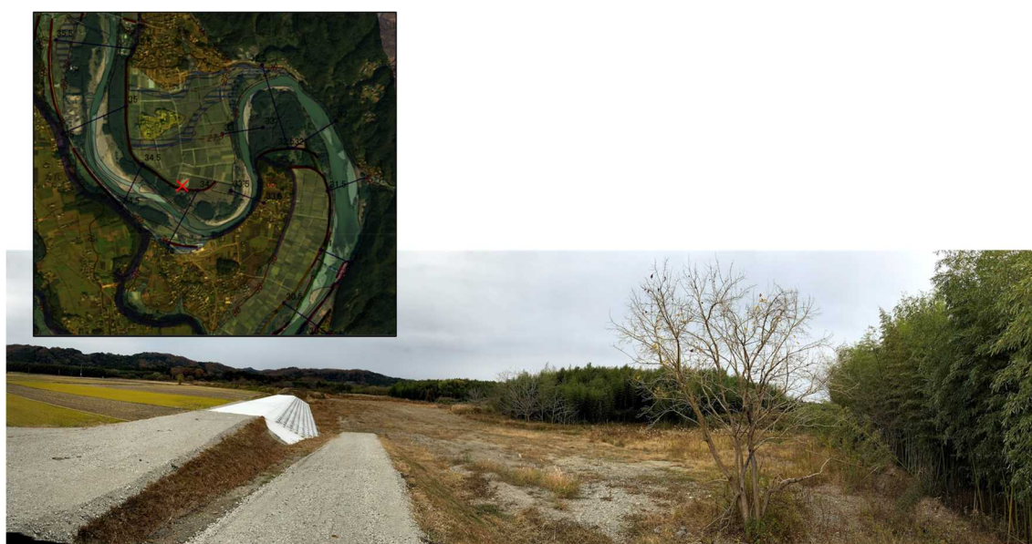
図 2-2-9 水害防備林の切れ目からの被災事例
