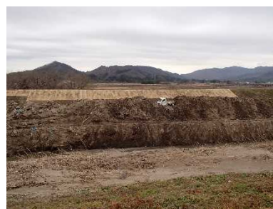
破堤箇所の復旧整備（右岸） 写真 2-1-3 内川右岸堤防の被災後改修（2019. 12. 25 撮影）
