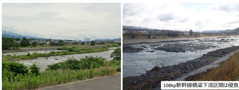
図 2-3-6 急勾配区間の激しい河床変動（108kp 付近、洪水前後）
