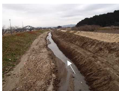
破堤箇所の復旧整備（右岸） 写真 2-1-3 内川右岸堤防の被災後改修（2019. 12. 25 撮影）
