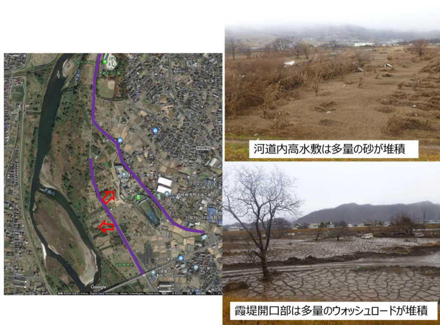
図 2-3-11 勾配変化点付近の 83kp 高水敷と霞堤遊水地の土砂堆積状況
