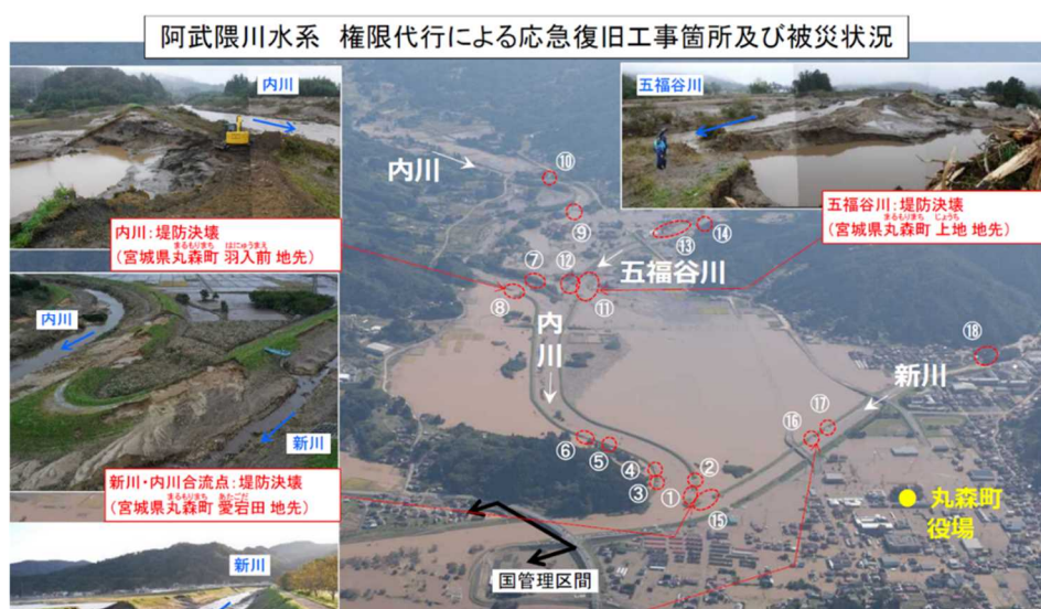
図 2-1-10 浸水被害の状況
