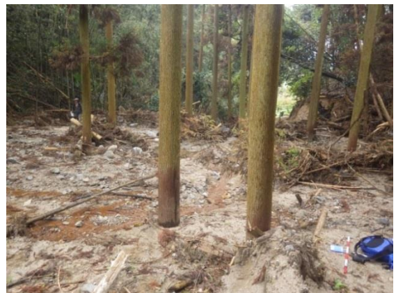
土砂・流木止め林(その1) 堆砂状況 2017/11/14
