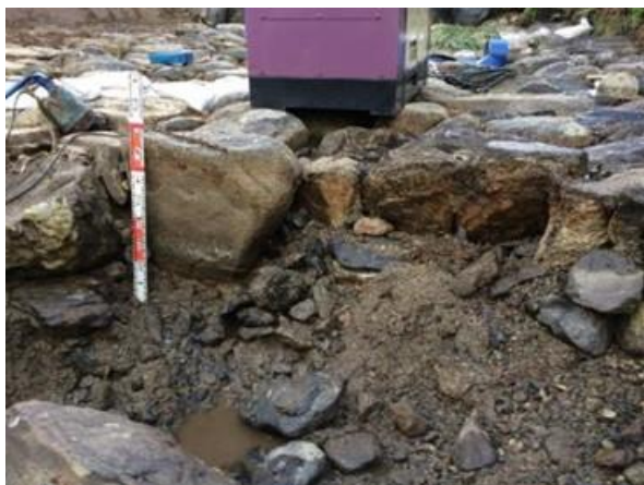
図 3.1.9 護床工および護岸の内部構造調査の様子
