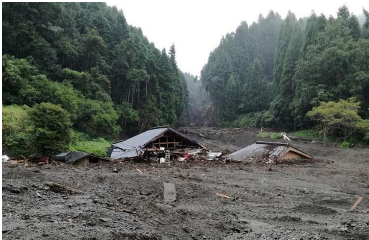
図 3.1.5.7 砂防ダム下流の住宅は被害を受け死者が出た
