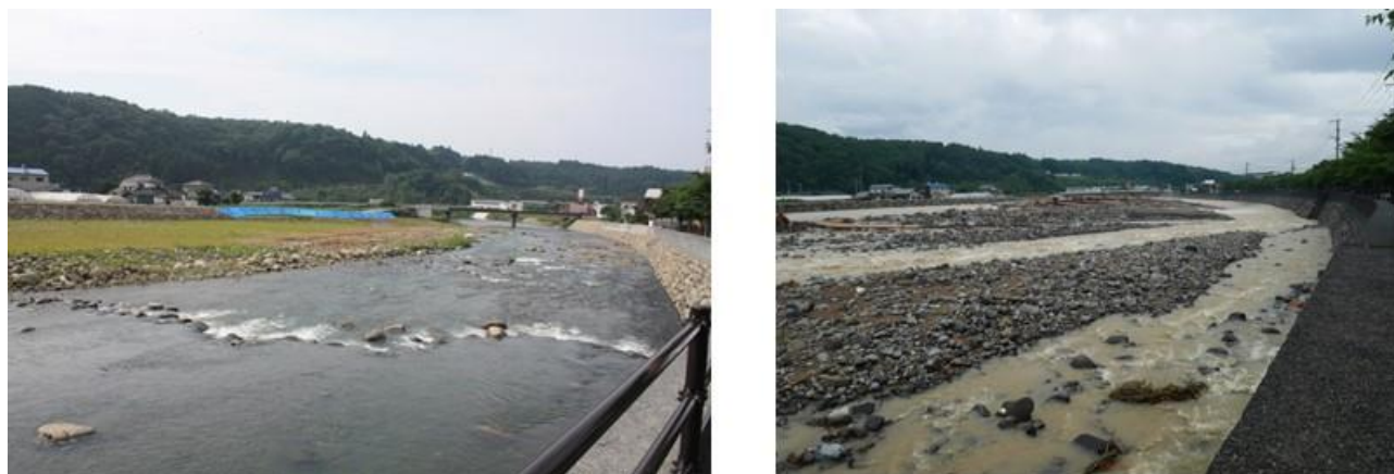
図 3.3.9 藤山地区の河道状況（左：平成 26 年施工後，右：平成 29 年 7 月 7 日）
