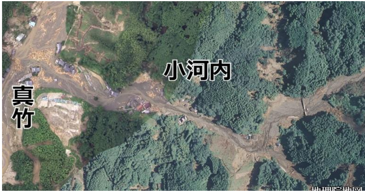
図 3.1.5.5 被害後の空中写真 上流部の家屋は見られず、谷全体が河川となっている
