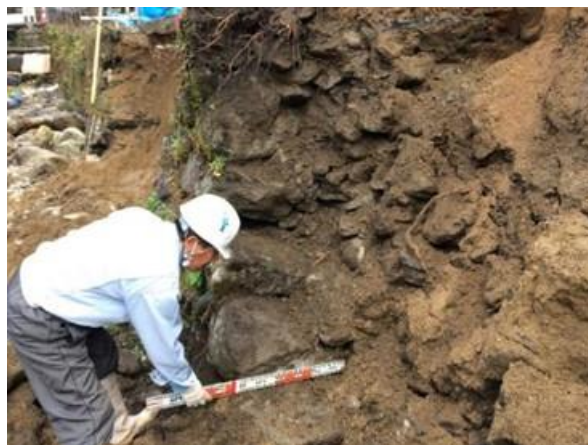
図 3.1.9 護床工および護岸の内部構造調査の様子
