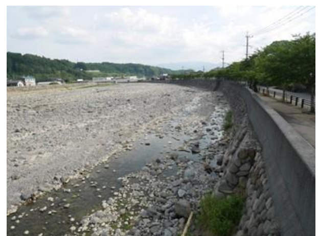
図 3.3.13 平成 30 年 7 月の藤山地区の状況
