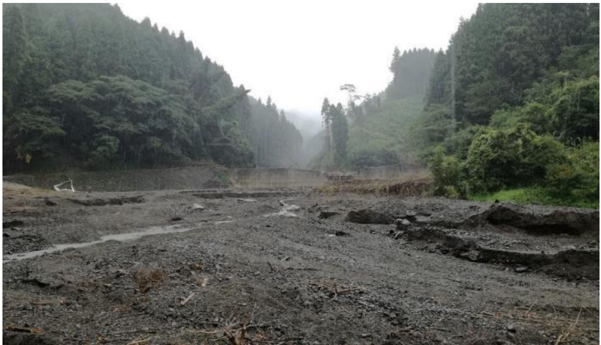
図 3.1.5.6 図 3.1.5.5 の右側に見える砂防ダムを土石流は乗り越えた
