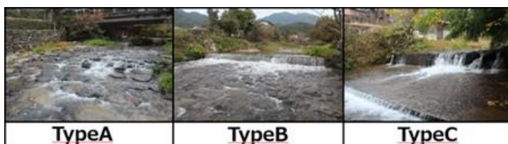
図 3.1.3 護床工のタイプ分類
