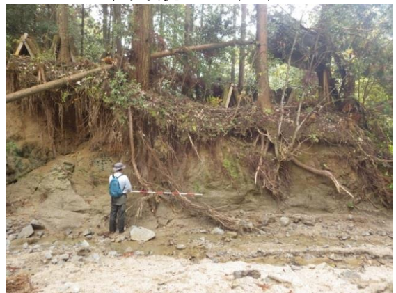
土砂・流木止め林(その1)脇での根系発達状況
