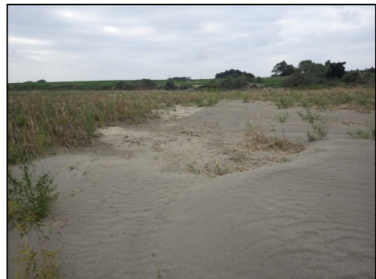
図-10 破堤箇所付近に生じた砂の堆積
