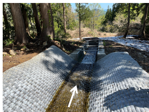
図 2.側部緩傾斜水路
