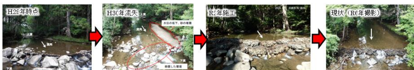
図-3 B 淵の施工状況
