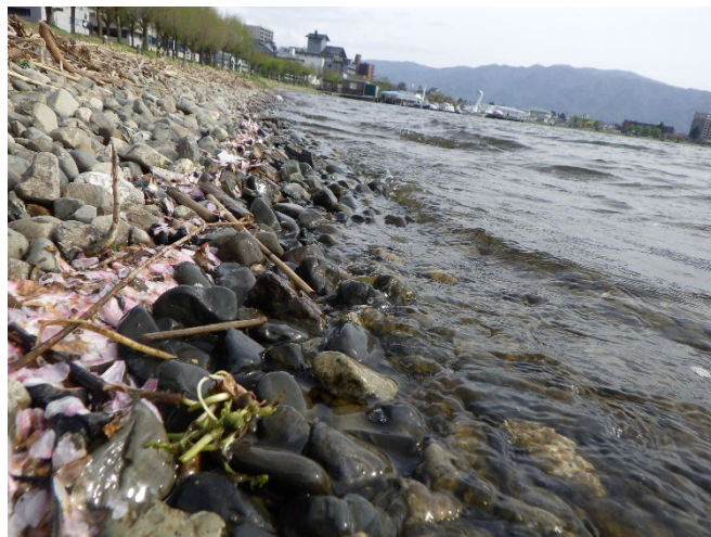
図2 湖岸に造成されたなぎさに打ち寄せる波浪
