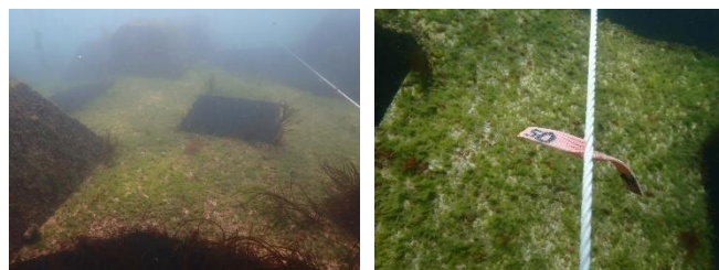
図2 根固めブロック（左）と表面の海藻類（右）
