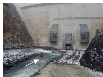
図-1 ダム上流から見た河床部放流設備の状況
