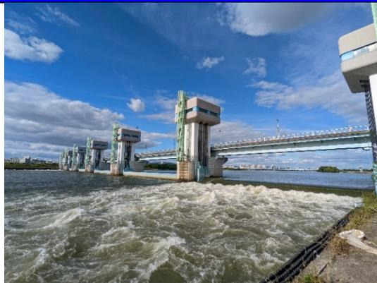
淀川大堰は淀川河口から9km 地点に設置され、その上流 10km 区間の湛水域の堆砂は、現在は毛馬閘門を通じて船舶により旧淀川へ運搬されています。淀川大堰で建設中の大堰閘門の完成後は、土砂を直接大阪湾へ運びだすことが可能となるので、「砂の道」としての活用方法についても考えたいと思います。ここでは、旧淀川への流量を調節している毛馬水門も見学します。
