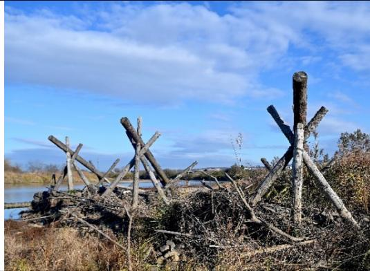
木津川下流部の 15-20kp には、平成 29 年から 5 ヶ年にわたり合計 16 基の中聖牛が設置されています。15kp 砂州では、中聖牛設置後に砂州頭と砂州尻に裸地が伸長し、大小様々なたまりが形成されています。これらの地形変化を確認し、中聖牛が土砂管理施設として河川環境改善に果たす効果を考えます。また、中聖牛を製作・設置した地元の NPO の方の話も聞きます。
