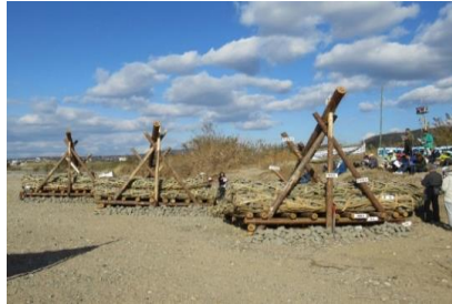
図1 木津川に施工された聖牛
