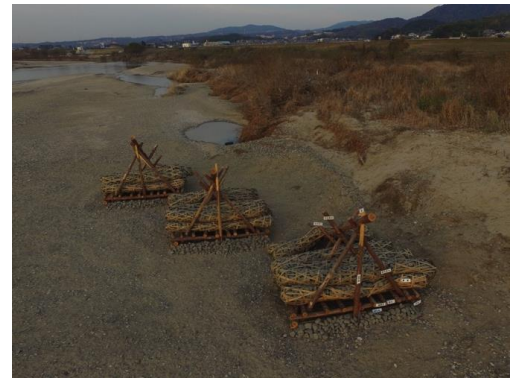
図1 木津川に試験施工された中聖牛
