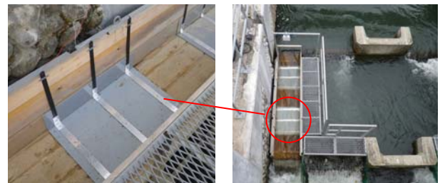
写真-1 仮設水路(右)と電極棒(左)
