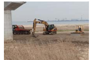
砂洲の復元工事の様子 (2017.4.21撮影)
