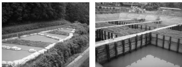
写真1 沈砂池の設置状況
