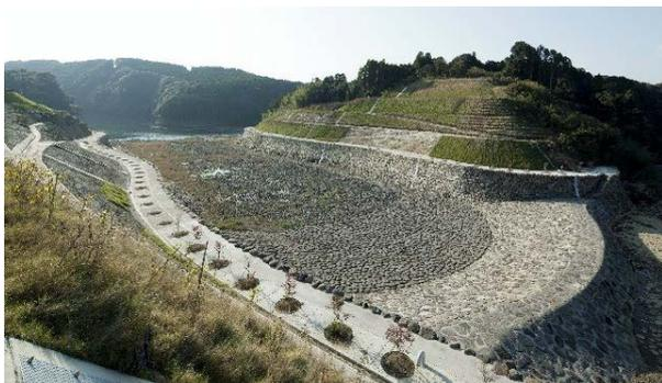
写真1 蛇行した河道部を開削した推込分水路
