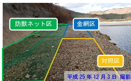
図-2 防獣ネット及び金網の設置状況
