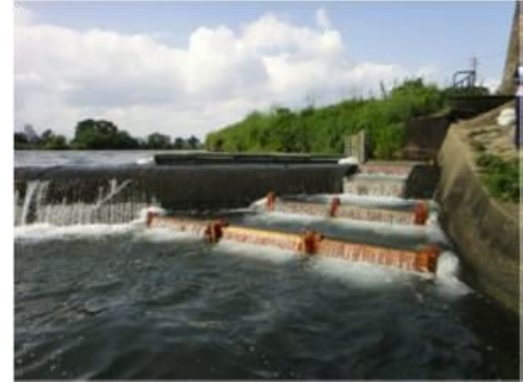
図 1 鴨川最下流の龍門堰。H23～25 年に魚道を設置。H26 年に堰の上半分が撤去され連続性阻害が軽減された。
