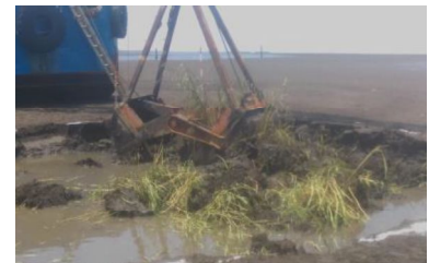
図1. 浚渫船によるヒガタアシ掘削防除
