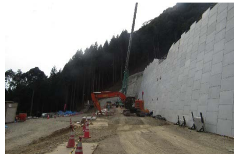
砂防堰堤建設現場の様子
