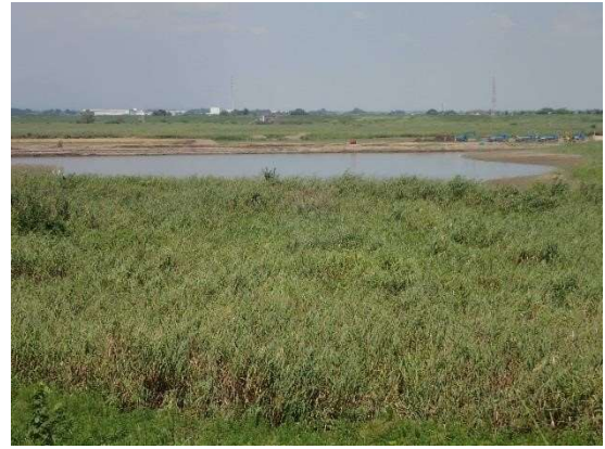
渡良瀬遊水地の掘削箇所
