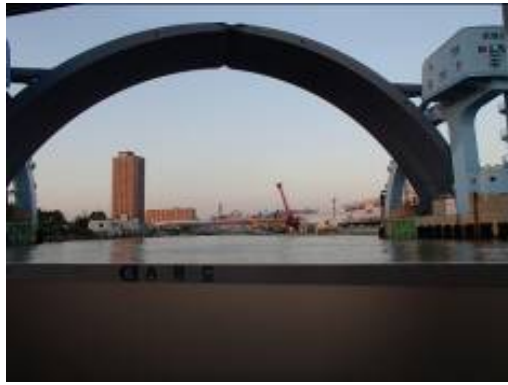
巨大な防潮水門 尻無川河口
