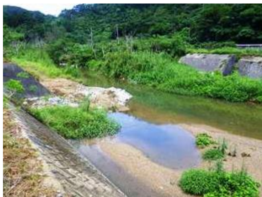
奥川第2落差工の撤去後の状況 (奥川第2落差工撤去後に形成された低水路)
