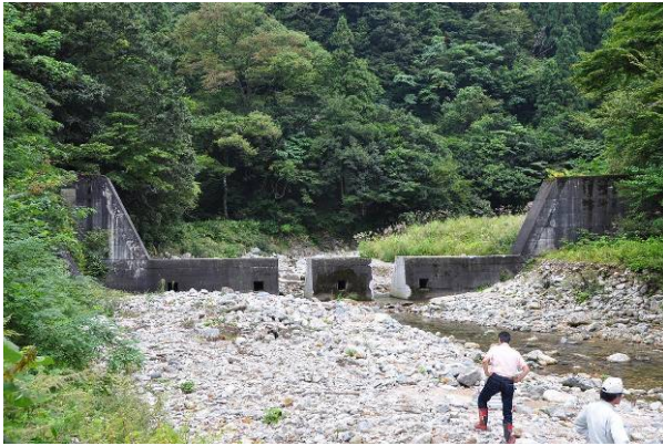
スリット化された堰堤
