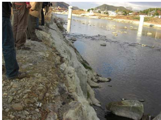
対象区間の河川全体を約 2m 掘削
