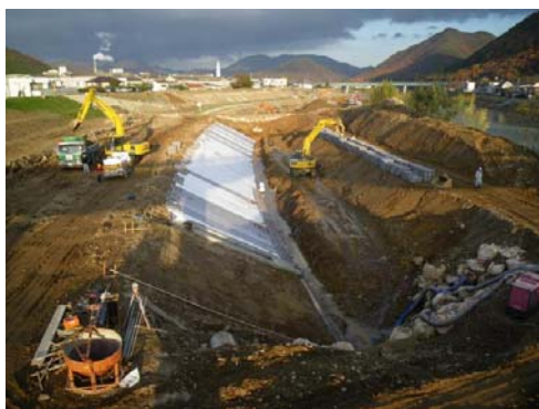
堤外水路施工状況
