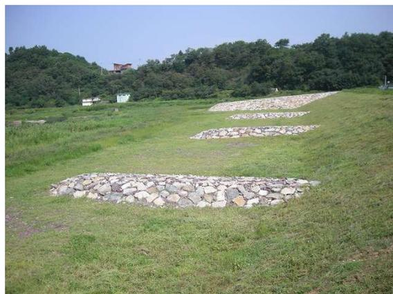
写真2-5 設置された水制と導流堤(最も奥側)
