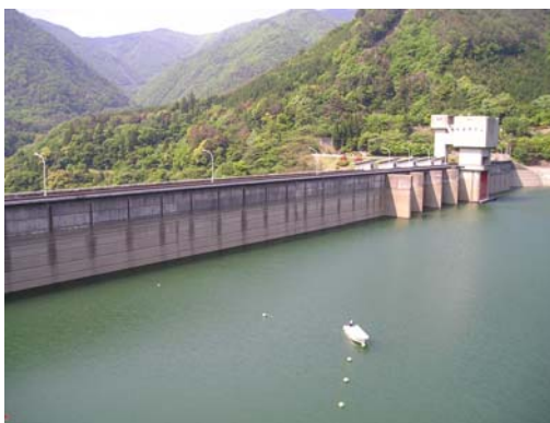
永源寺ダム (管理事務所より望む)
