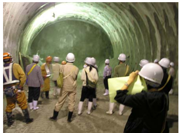
トンネル切羽の状況
