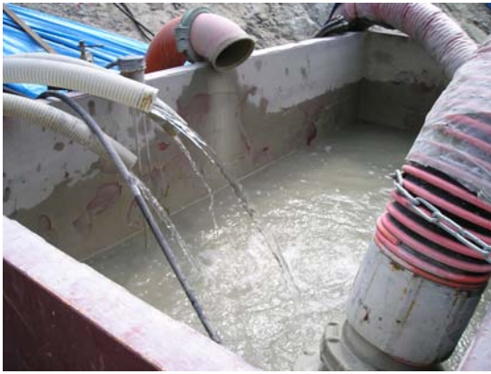
濁水を沈砂設備に集水
