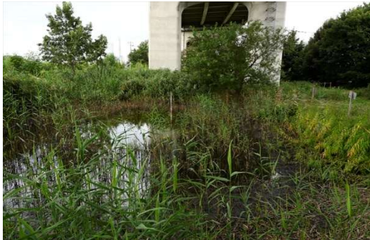
首都高の高架下に整備された池沼
