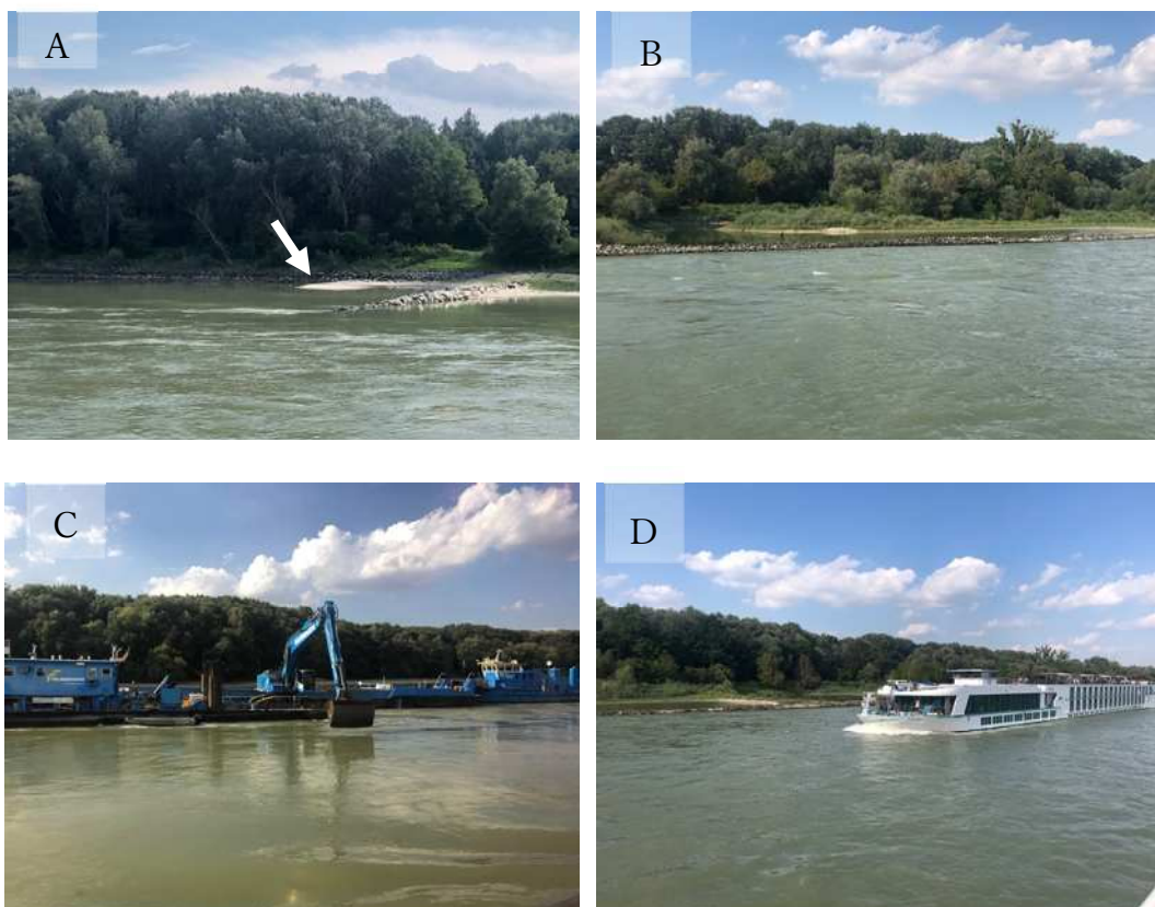
写真 3. ドナウ川における Integrated River Engineering Project の現地視察。(A) 石積みの水制（矢印）。同様の水制が数多く設置されています。(B) Donau Auen 国立公園に面した河畔林と、石積みで囲まれた止水帯。岸際の浅瀬や砂州には、水鳥が集団営巣地を形成するようです。(C) 河道内に堆積した土砂を掘削する重機。(D) 観光客を乗せた大型の遊覧船。
