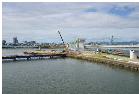
建設が進む淀川大堰閘門
